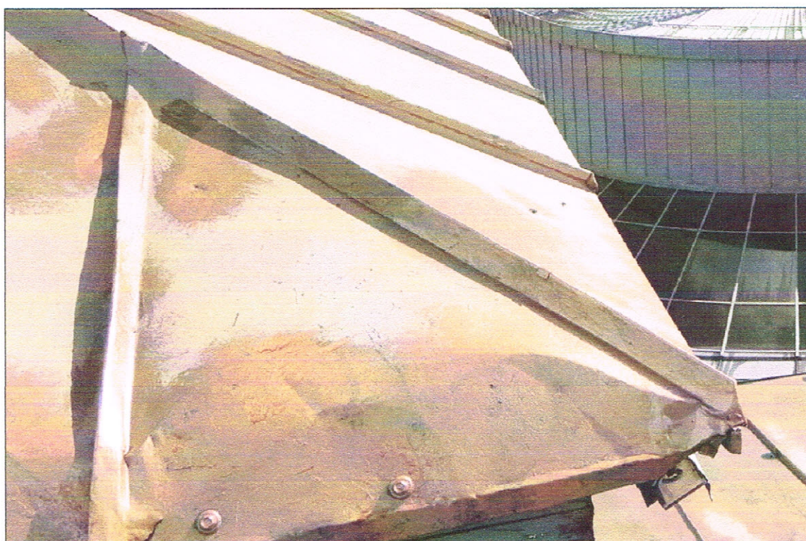
10.fotoattēls. Jumta seguma krāsojuma bojājumi
